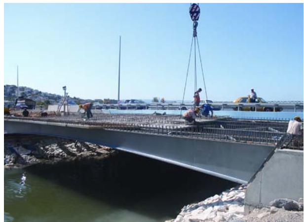
Slika 16. Završni radovi na mostu Žrnovnica na splitskoj obilaznici
