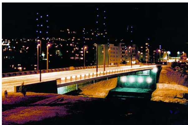
Slika 6. Pogled na most Hasan Brkić u noći u Mostaru
