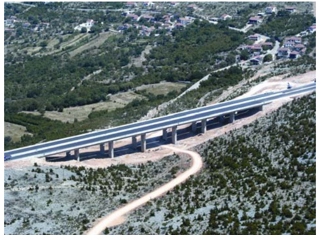
Slika 12. Vijadukt Rovanjaska na autocesti Zagreb – Split
