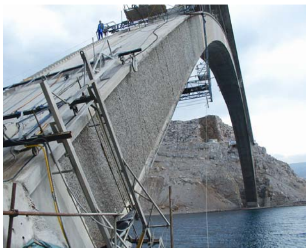
Slika 19. Skela za hidrodinamičko uklanjanje oštećenja lučnih mostova na mostu kopno – otok Krk
