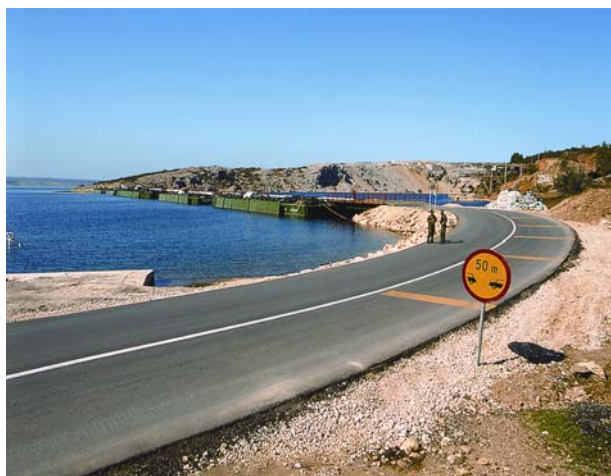
Slika 1. Pontonski most preko Novskog ždrila s prilaznom cestom
