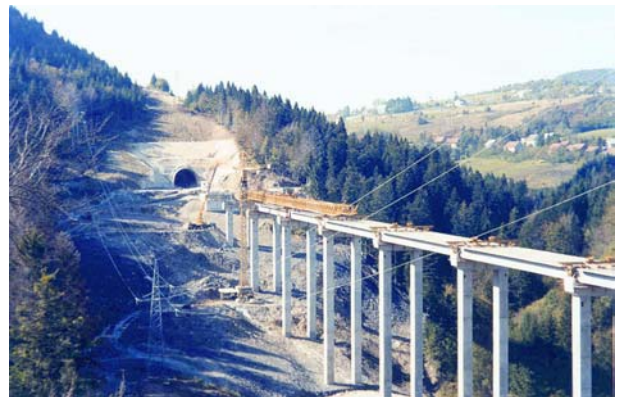
Slika 13. Montaža nosača uz pomoć "lansirke" na vijaduktu Stara Sušica na autocesti Rijeka – Zagreb
