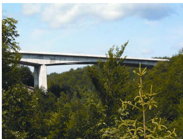
Slika 7. Most Kamačnik na autocesti Rijeka – Zagreb
