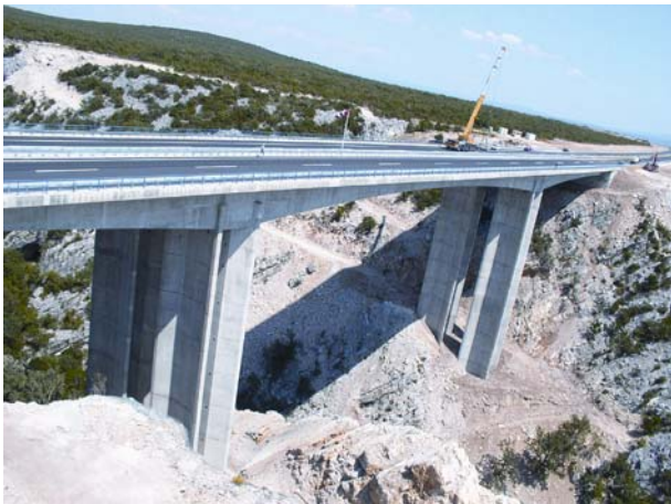
Slika 8. Most Guduča na autocesti Zagreb – Split
