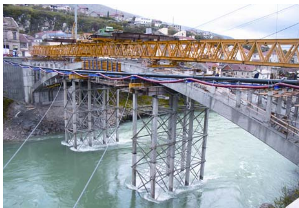
Slika 5. Gradnja replike Lučkog mosta u Mostaru
